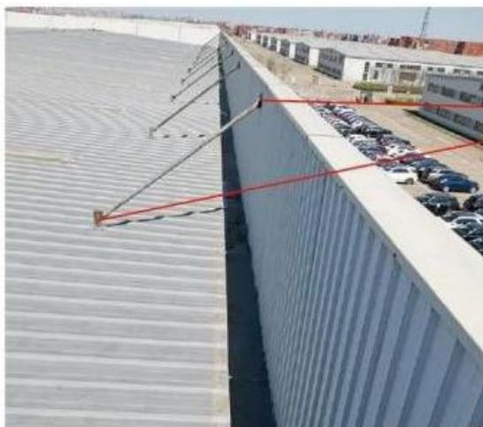
斜拉支撑基座根部用欧贝力防水涂料进行涂刷密封, 涂刷前将基层锈蚀部位打磨清理干净。
